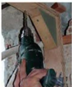
Αν το κούφωμα τοποθετηθεί περασιά μέσα, τότε η ψευτόκασα θα τοποθετηθεί δυο εκατοστά έξω από την εσωτερική πλευρά της τοιχοποιίας, εάν δε το κούφωμα τοποθετηθεί στην μέση του λαμπά, σε εκείνη τη θέση θα τοποθετηθεί και η ψευτόκασα.
