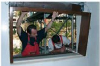
Πριν το "σπίκωμα" του κασώματος, στο άνοιγμα στρώνεται ελαστομερές στη μαρμαροποδιά ώστε το κατωκάσιο να πατήσει σε παχύ στρώμα υλικού. Το συνεργείο τοποθετεί (σπικώνει) το κούφωμα στο άνοιγμα και το ακινητοποιεί με ξύλινες σφήνες.
